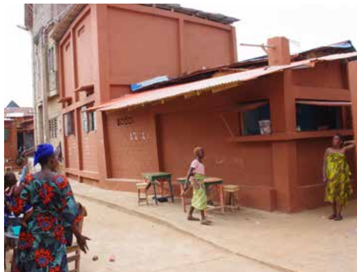
Après les travaux
