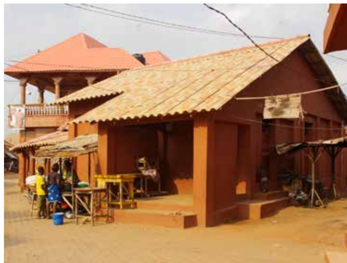
Après les travaux
