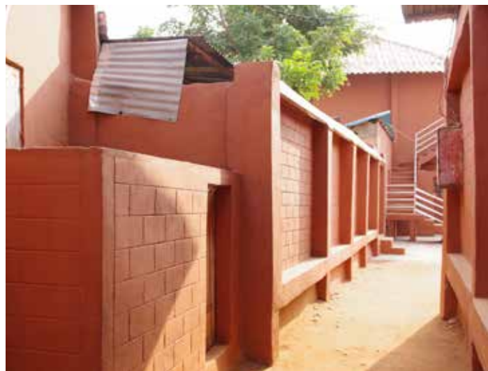
Après les travaux
