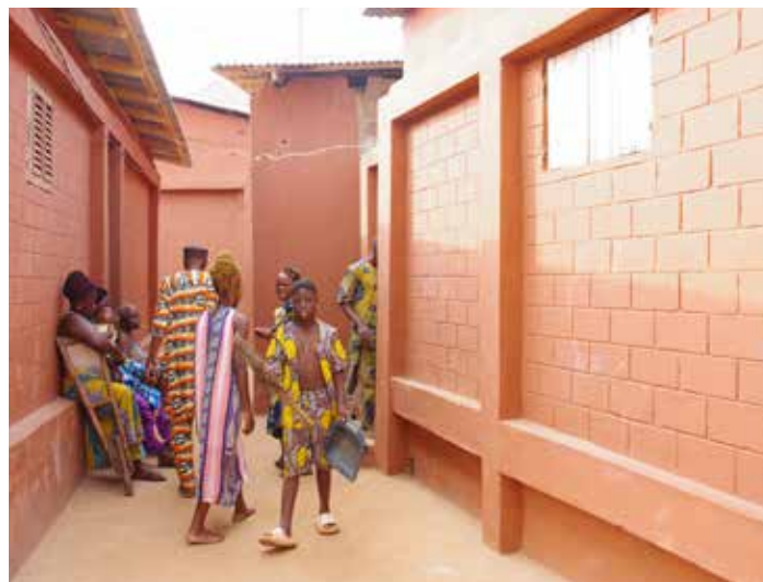
Après les travaux
