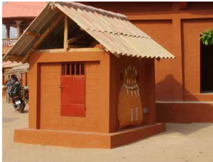
Après les travaux
