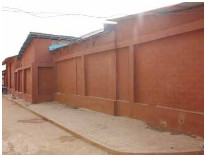
Après les travaux
