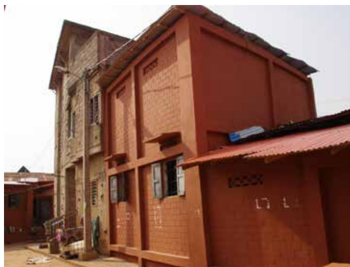
Après les travaux
