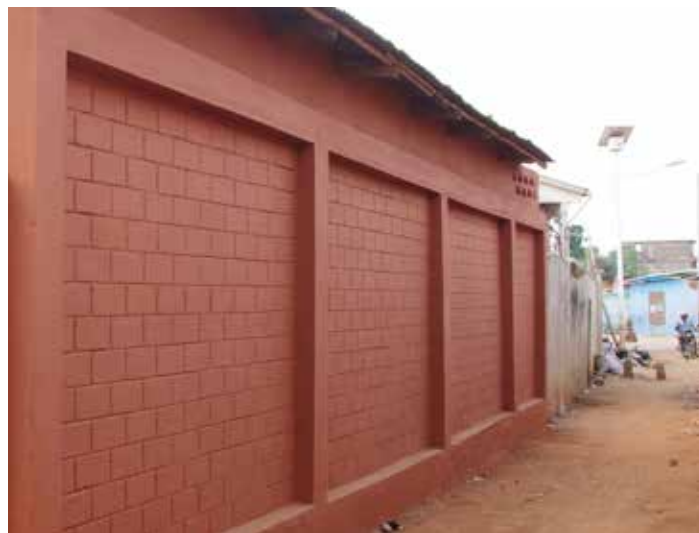
Après les travaux
