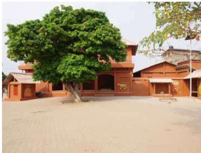
Après les travaux
