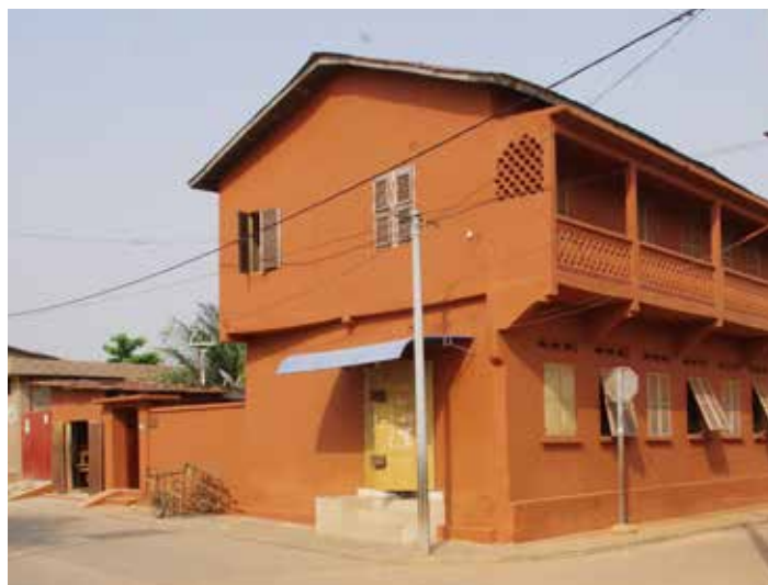
Après les travaux
