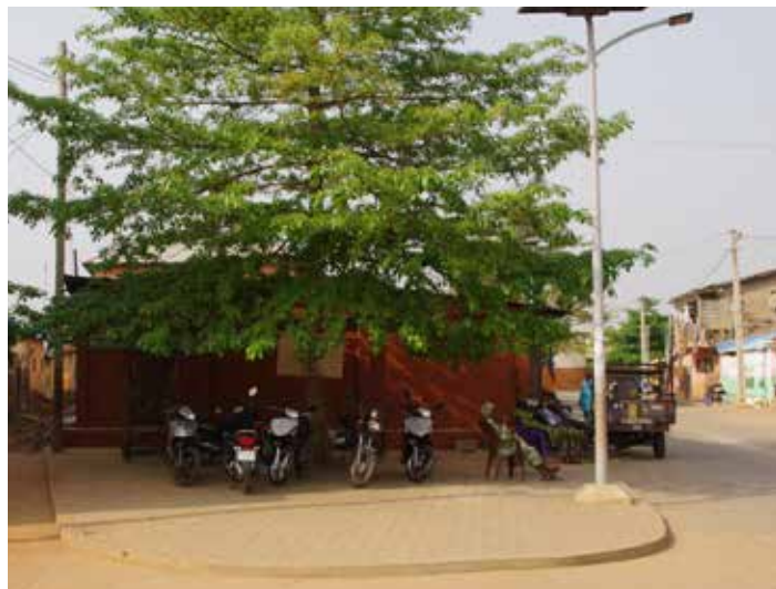
Après les travaux
