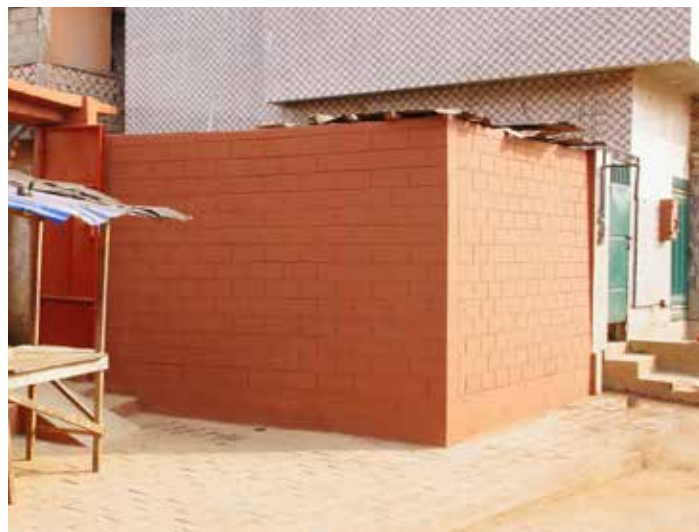
Après les travaux
