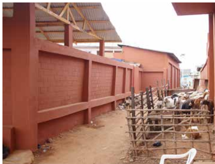
Après les travaux
