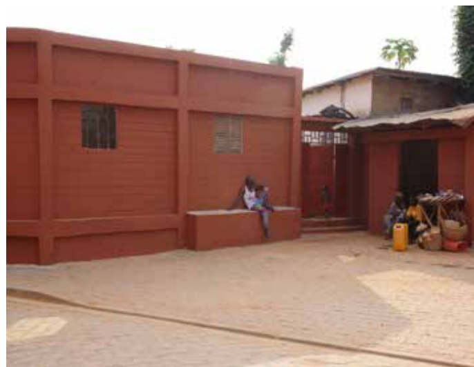
Après les travaux
