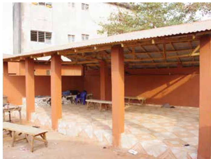
Après les travaux
