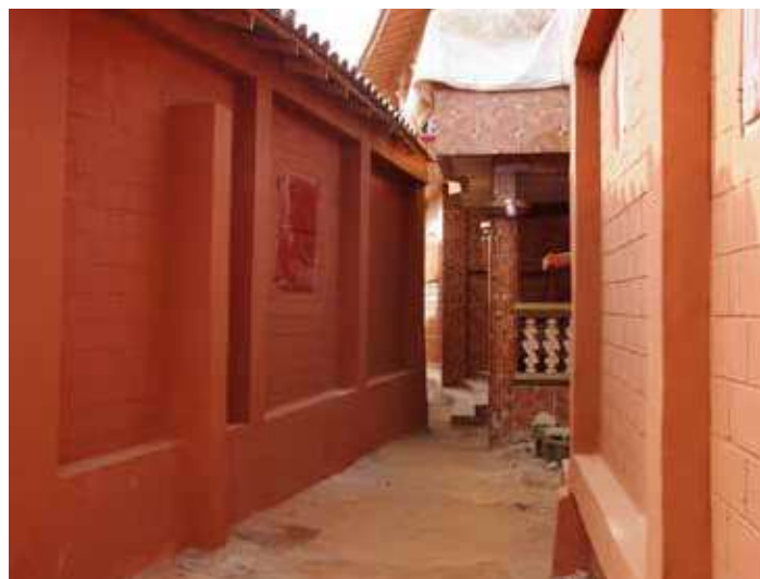
Après les travaux
