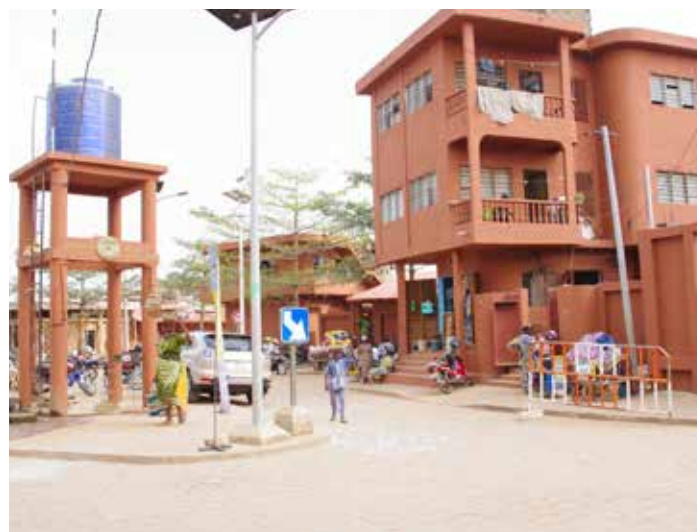
Après les travaux
