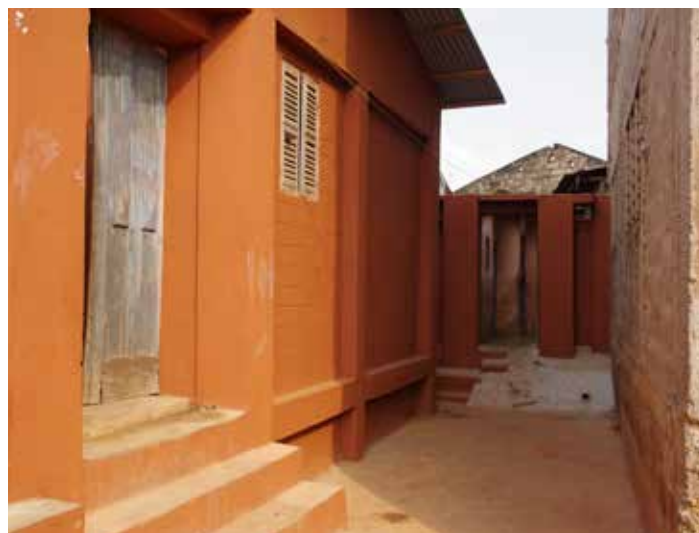
Après les travaux
