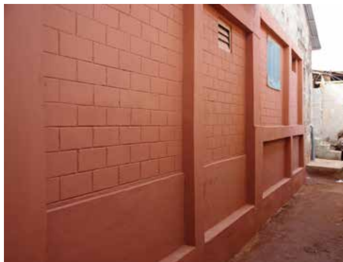
Après les travaux
