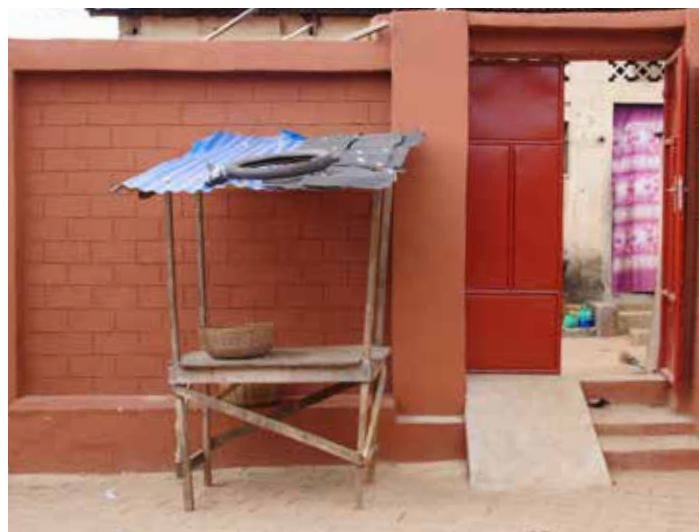
Après les travaux
