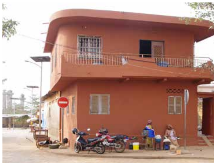
Après les travaux
