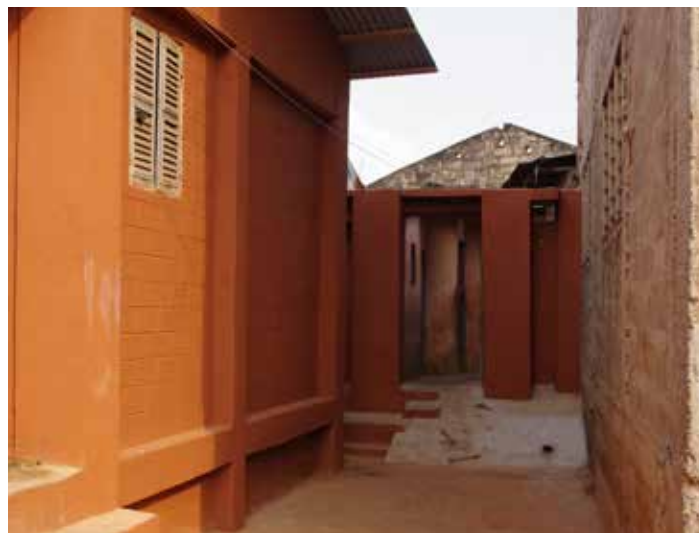
Après les travaux
