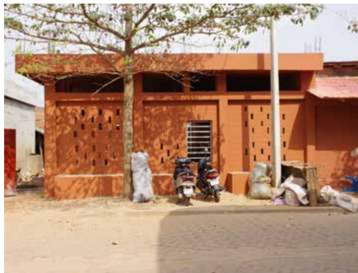
Après les travaux
