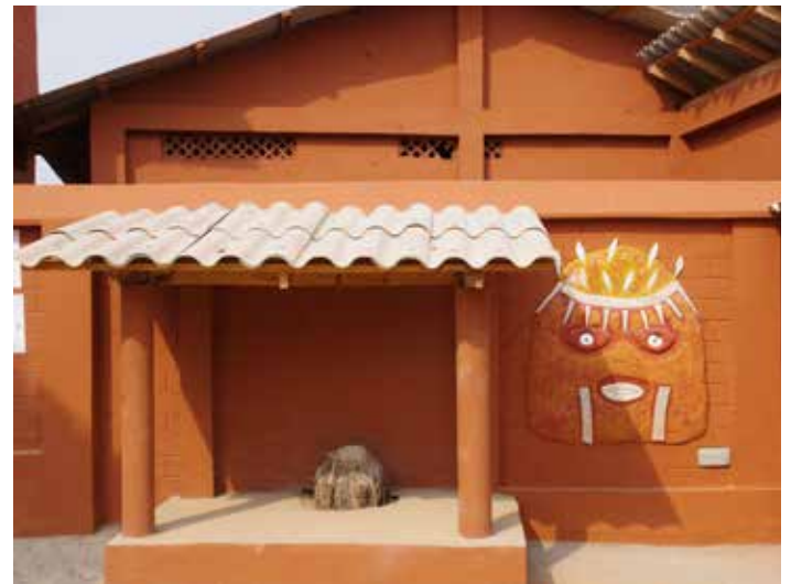
Après les travaux
