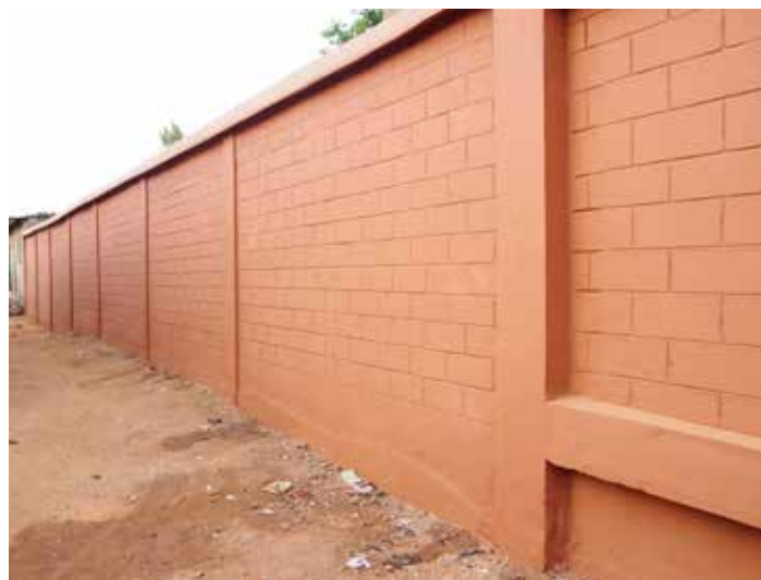
Après les travaux
